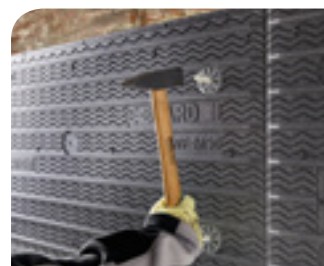
Isolatieplaat bevestigen
