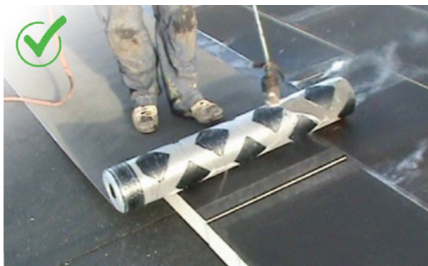
Figuur 8: Aanbrengen met brander op een PIR-isolatieplaat om goede praktijk aan te geven (links: partieel gekleefde basislaag met brander op rol; rechts: brander op isolatieplaat)
